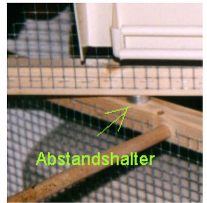
Im nächsten Arbeitsschritt wird von innen auf die Wände und von außen auf das Dach Volierendraht getackert. Der Volierendraht läßt sich mit einer Draht- und Blechschere recht einfach zurecht schneiden. Auf die Draht-Schnittkante an den Wänden wird jeweils eine in der Länge angepaßte Eckleiste geschraubt, um den Abschluß des Drahtes zu verdecken. Denn erstens reduziert es die Verletzungsgefahr, zweitens ist die Reinigung einfacher und drittens sieht's besser aus.
