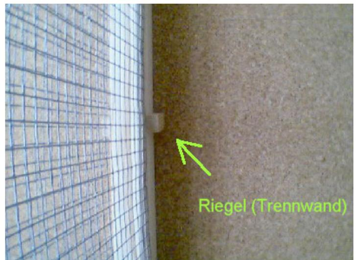
Die Trennwand besteht hier aus einem einfachen Rahmen mit einer waagerechten Stabilisierungsstrebe. Damit sich Hähne nicht gegenseitig durch die Gitter attackieren können wird diese beidseitig mit Volierendraht gespannt. Zur sicheren Fixierung der Trennwand werden mindestens vier solcher Doppelriegel benötigt. (2 an der Rückwand, 1 am Dach und 1 im unteren Drittel vorne)
